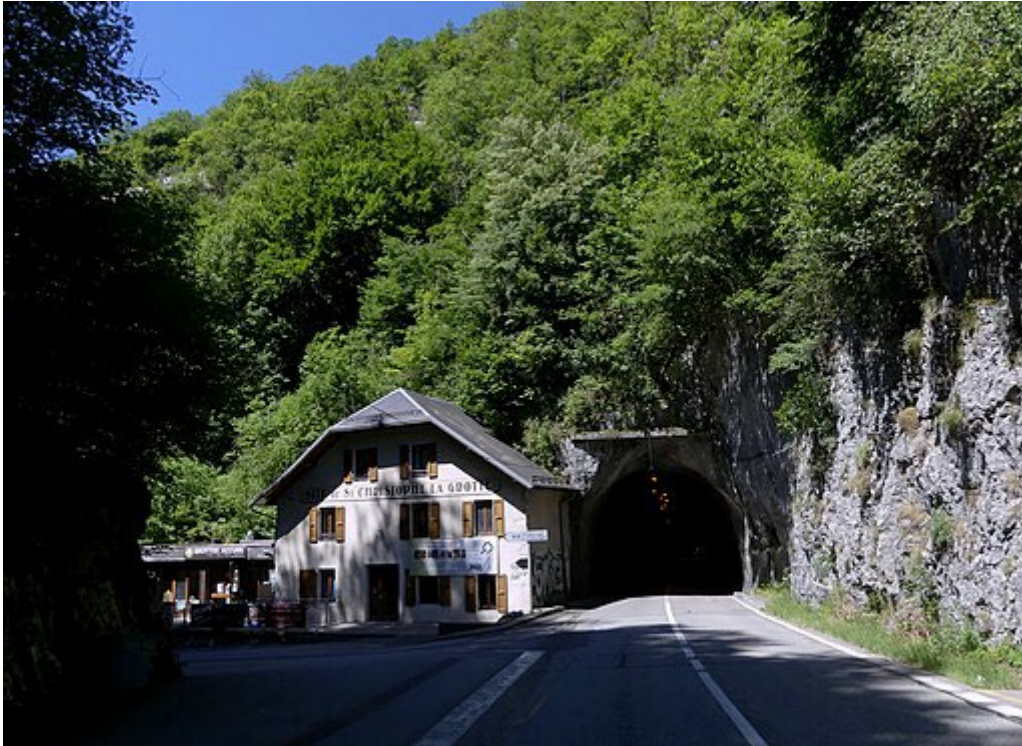
Tunnel des Échelles (Route départementale 1006 de Chambéry en direction de Lyon, en Savoie. © Florian Pépelin, CC BY-SA 4.0
