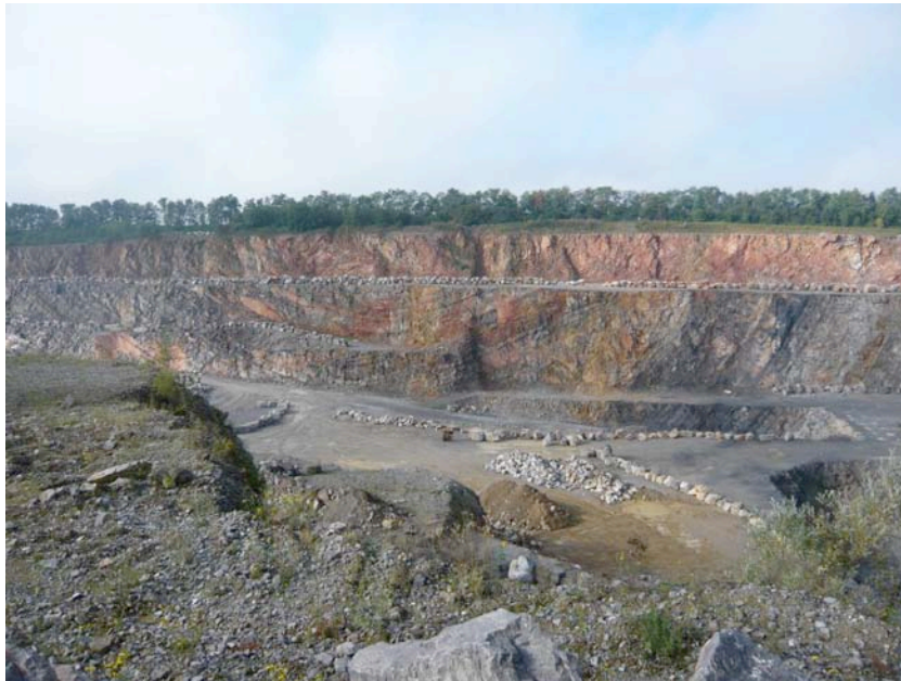
Figure 2 — Vue du flanc W de la carrière 3 de Haut-Lieu : coupe N-S du synclinal d'Avesnes (le N est à droite). Une faille de charriage est observable à droite du cœur du synclinal.
