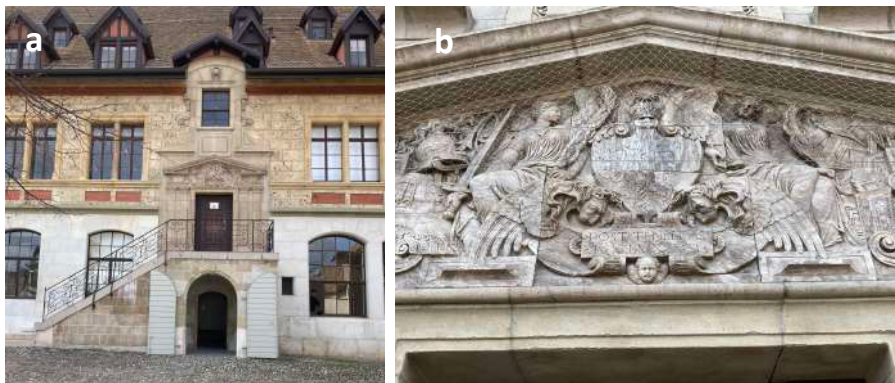
Figure 35 a: rampe et porte d'entrée de l'aile sud depuis la cour du collège en Molasses diverses; b: bas-relief en marbre bicolore au-dessus de la porte .
