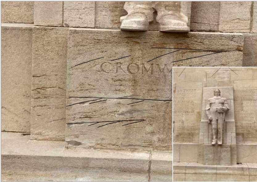
Figure 19: Pierre de Pouillenay, Mur des réformateurs; structures sédimentaires au pied de la statue de Cromwell.
