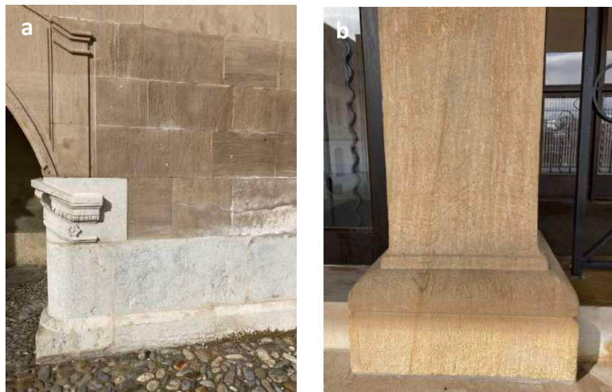
Figure 36: détails de la rampe et de l'entrée du bâtiment central; a: transition Calcaire blanc /Molasse (mauvaise restauration), b: pilier en calcaire jaune (probablement une roche calcaire de Neuchâtel ?).
