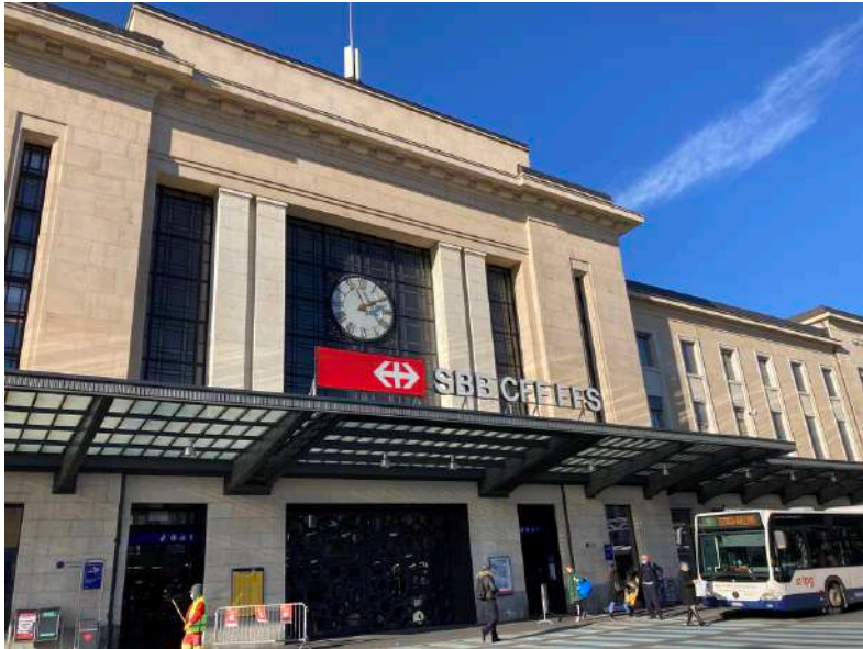
Figure 50: façade de la Gare de Cornavin en Pierre de Savonnières sur une base en Granite du Tessin.
