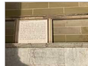
Figure 43: Musée Rath, un bâtiment typique en Molasse grise fortement altérée.
