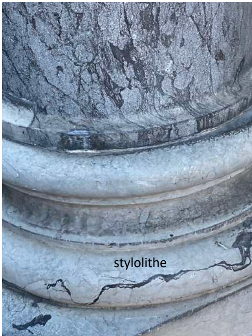
Figure 9: pied d'une colonne du portail d'entrée de l'Hôtel de Ville en Marbre de Saint-Triphon; calcaire noir, fortement bioturbé, parcouru de stylolithes (surfaces de dissolution) et riche en fossiles.
