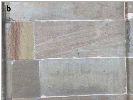
Figure 40 a: temple de la Fusterie, construit en Molasse rouge sur une base de Calcaire blanc; b: structures sédimentaires dans la Molasse rouge du temple de la Fusterie.
