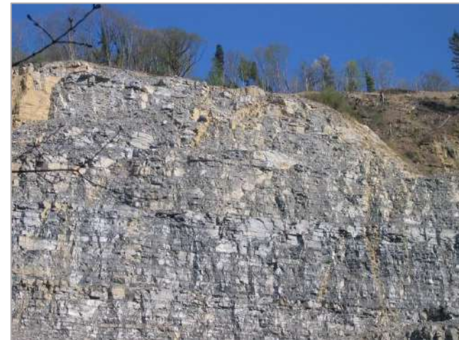
Figure 16: carrière de Meillerie (Haute Savoie); aspect typique de la formation exploitée qui comporte des couches régulières de calcaire siliceux.
