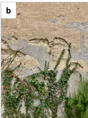
Figure 47: manège de Meyrin, construit en Pisé. Sur la façade nord-ouest le mauvais état du crépi laisse apparaître du Pisé, un mélange de matériel fin et de petits galets arrondis.
