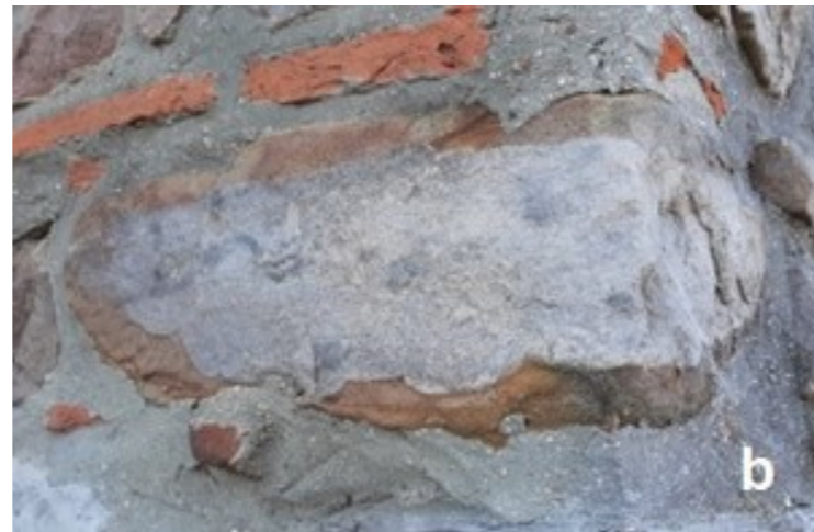
Fig. 4 : Eglise Saint-Martin de Nomain (a : vue générale / b : moellon bicolore en grès)
