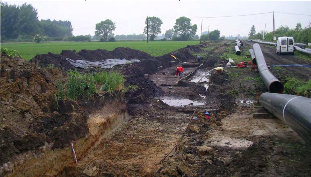
Illustration 39 - Franchissement du méandre de Vred et fouille
