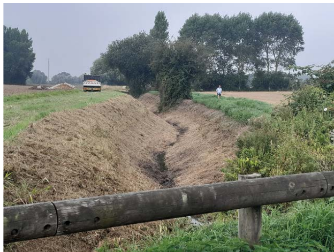
Fig. 4. - Surenretien d'une becque à l'aval de l'agglomération d'Herzelee, favorisant l'écoulement et la concentration du pic de crue (été 2023). Fig. 4. – Over-maintenance of a creek downstream of the Herzelee agglomeration, encouraging runoff and concentration of peak flooding (summer 2023).
