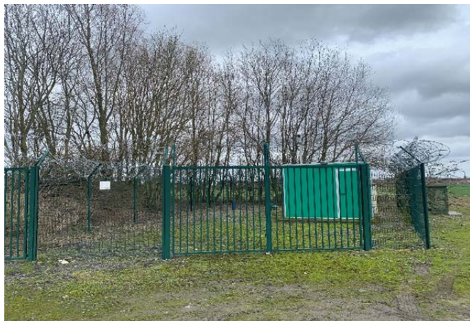
Fig. 4 – C – site de captage et une partie de ses protections. Fig. 4 – C - Catchment site and part of its protection.
