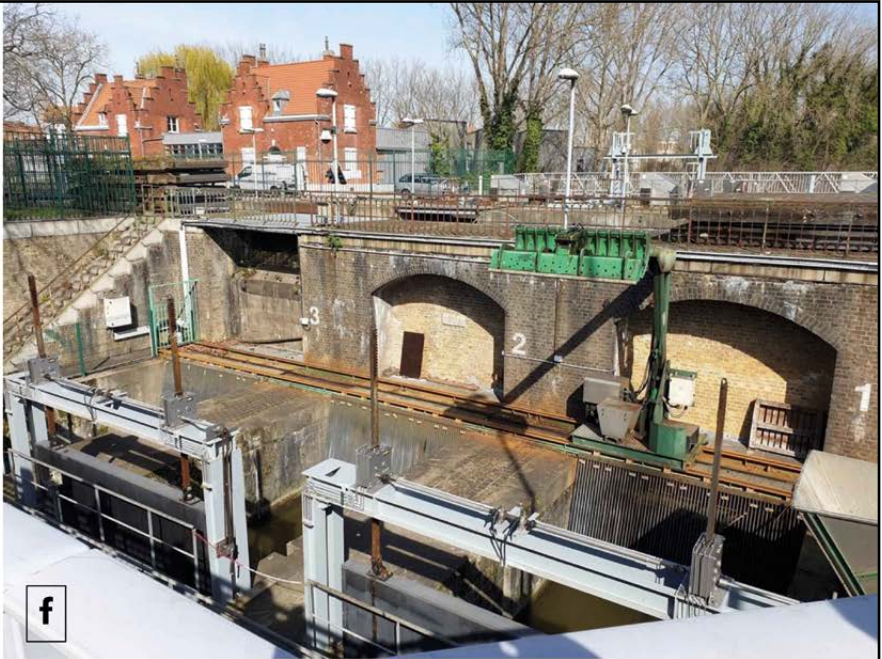
f Dégriilleur automatisé collectant régulièrement les embâcles venus de l'amont.
