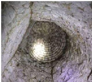
Les puits étaient fermés à la main, en utilisant des moellons disposés en encorbellement (assimilés « catiche »)
