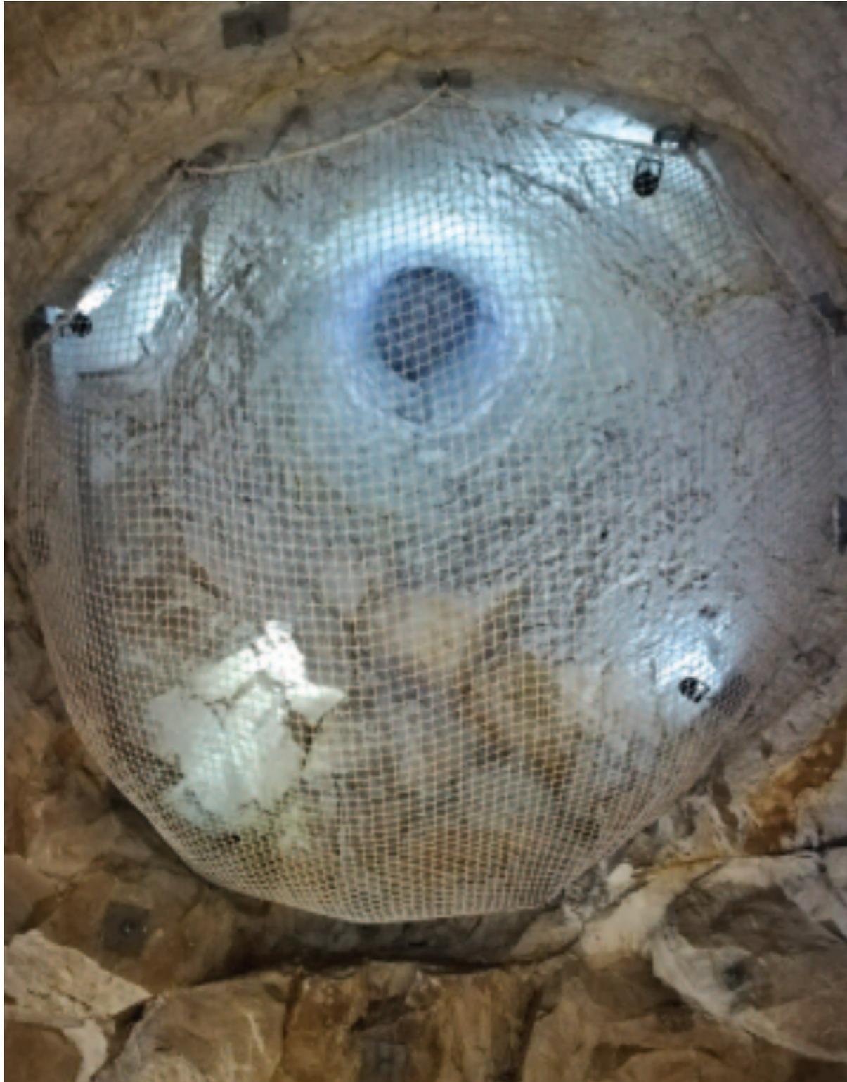
**Fig. 15 : Puits de carrière en « bouteille » vu depuis le dessous.** *Source : Y.Henry-SAM Arras*
